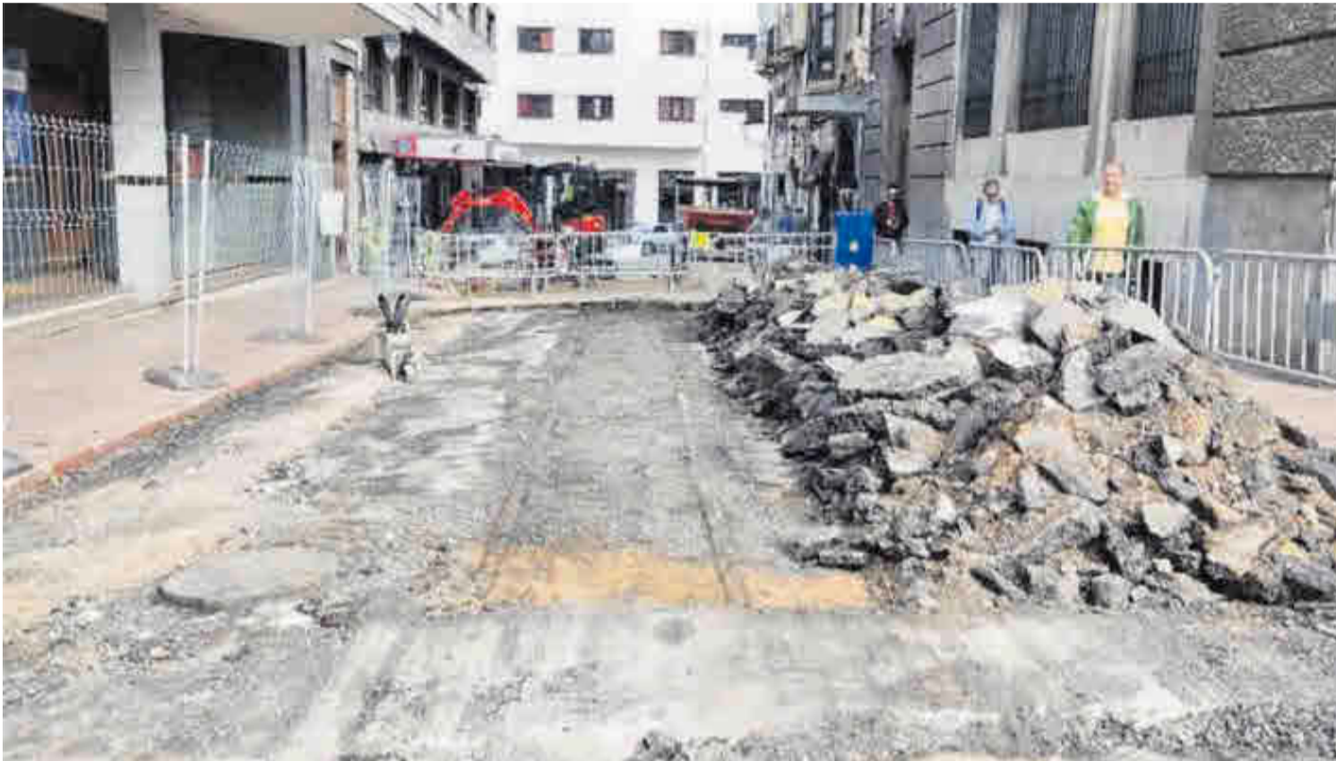
Inicio de las obras de peatonalización en la calle Mendizábal.
