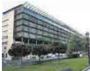
Edificio administrativo del Principado, en Oviedo.
